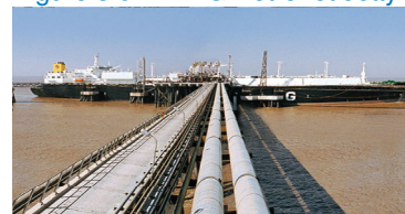
Figure 3.9: LNG Petronet Jetty
